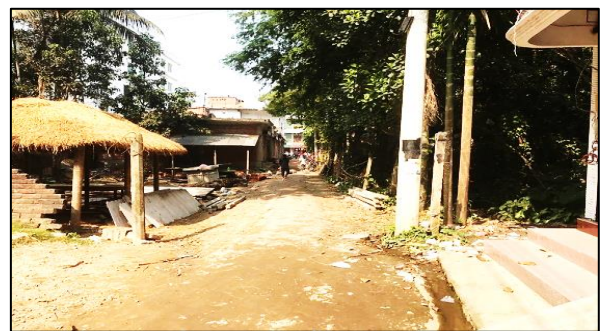
Drain-9 + R36 Alamdanga Pourashava
